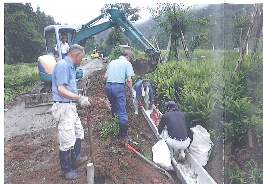
谷地のU字溝敷設
